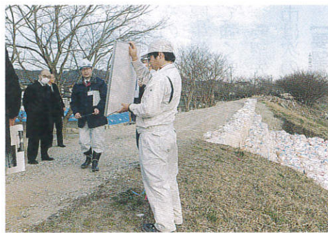
夏井川決壊箇所（いわき市）
